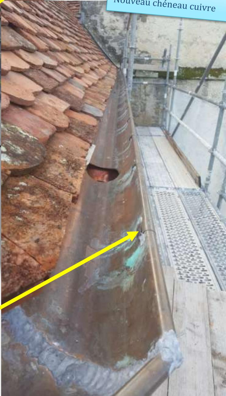
Paillette rabattue et maintenue par un pontet soudé sur la gouttière
