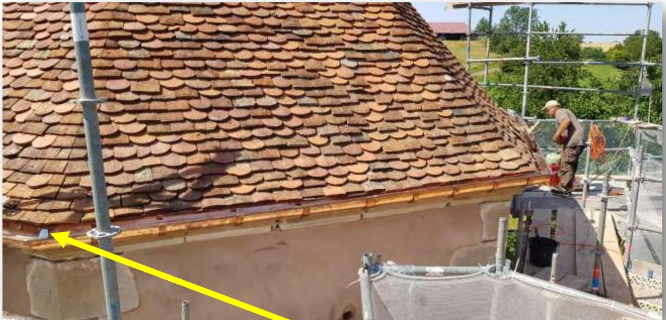
Dilatation réalisée par talon de dilatation
